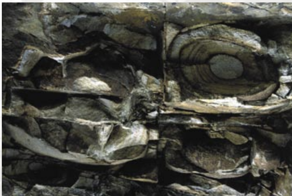
FIGURAS EN UN TALUD DESPUES DE UNA VOLADURA, Isidro Pastor Serrano
